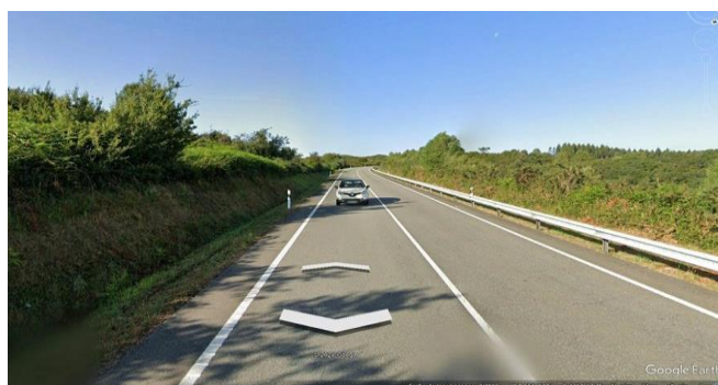
Zona no entorno do accidente no P.Q. 17+590 (sentido A Estrada)
